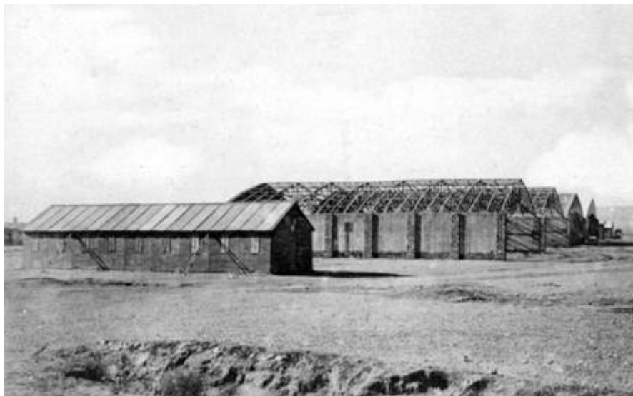
Bou Denib – Construction des hangars de l'aviation militaire
