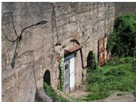
L'ancienne entrée de la mine d'Angevillers et la galerie de la poudrière
