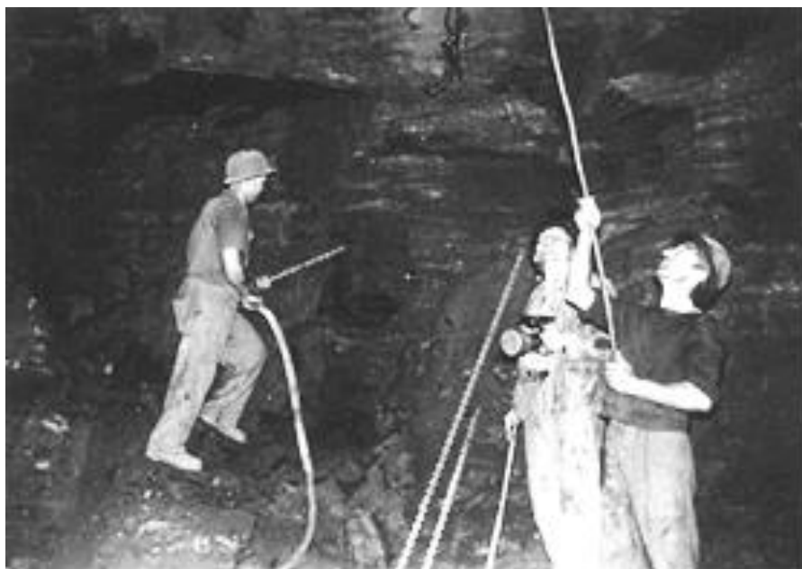
Forage des trous de mine avec un marteau pneumatique – Sondage de contrôle du toit
