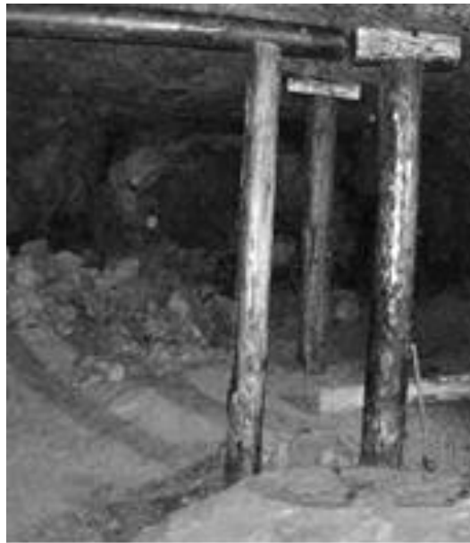
Chandelles de soutènement avec leur chapeau
