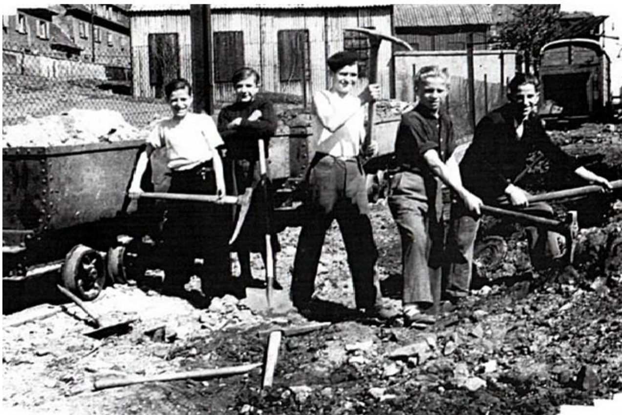
Vers 1946- 1947 : une des premières équipes du Centre aménageant le terrain des sports.
